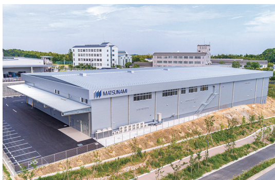
【松浪硝子工業 ゆめみヶ丘工場（同市）】
